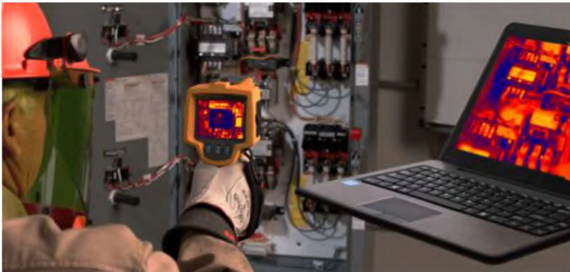
Рисунок 20. Пример проведения тепловизионного контроля электрошкафа
